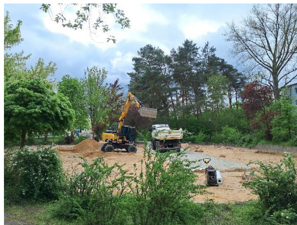
Ausheben des Sandes (Fallschutzes)
